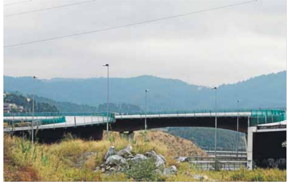
El viaducte inacabat que ha de permetre la connexió entre l'AP-7 i l'A-2 ■ ORIOL DURAN / ARXIU
