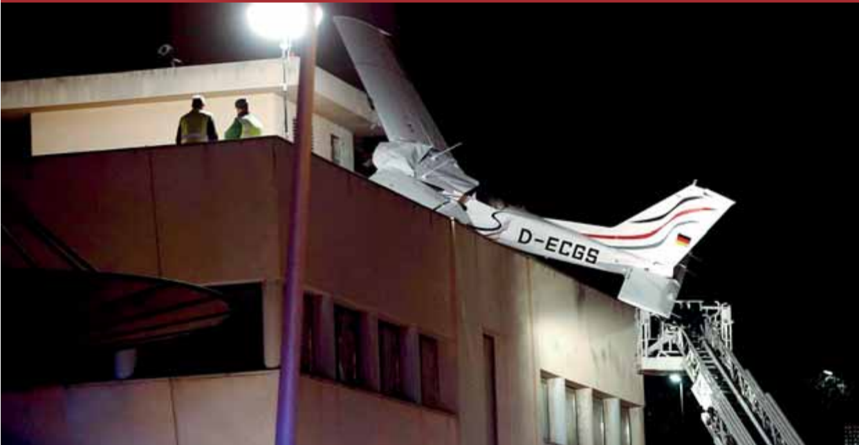
Els equips d'emergència treballant al terrat de la gasolinera on l'avioneta es va encastar ■ EFE
