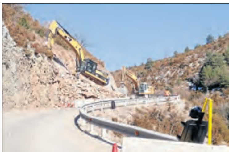
Obres d'estabilització del talús entre el Pont de Suert i Xerallo.
