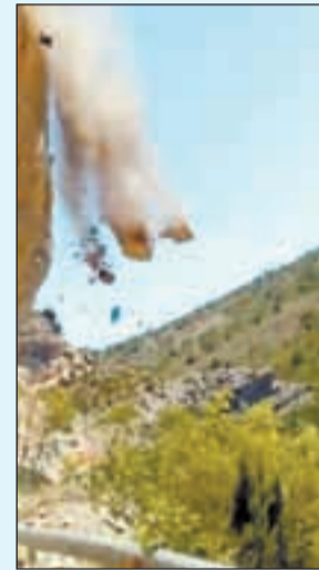
FOTO: J.N./ Es peligroso por los desprendimientos
