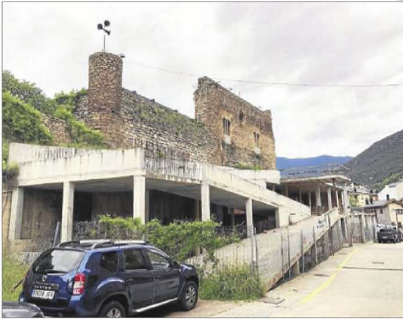
L'estructura de formigó que va quedar paralitzada el 2003.
