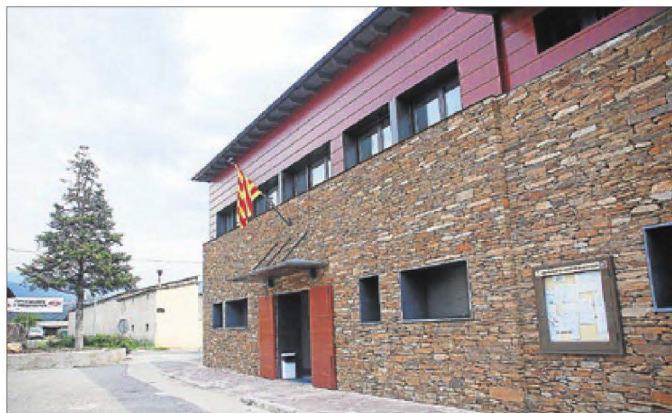
Matge d'arxiu de l'ajuntament de Montferri, que s'escalfarà amb una caldera de biomassa.
