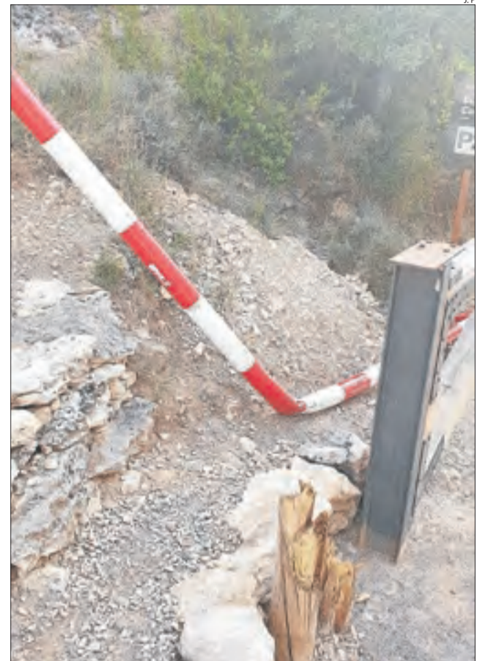
La barrera d'accés va ser arrancada del pal de fusta.
