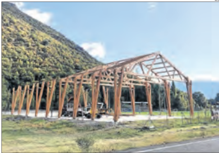
Imatge de les obres per cobrir la pista poliesportiva de Rialp.
