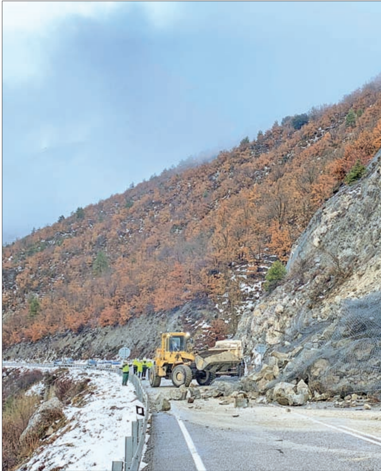
FOTO: Jordi Fàbrega/ Imatge de l'esllavissada que va tenir lloc ahir a la carretera N-260, al Pont de Bar
