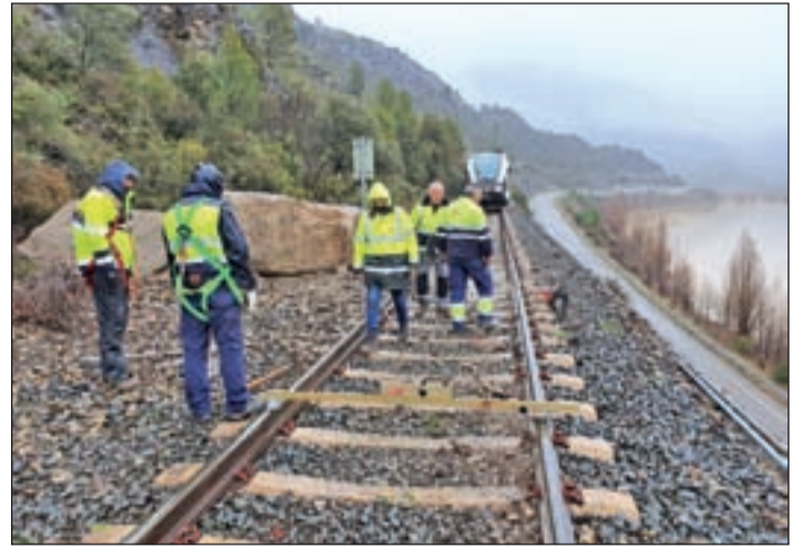
FOTO: FGC / Operaris reparant el tram malmès per l'esllavissada
