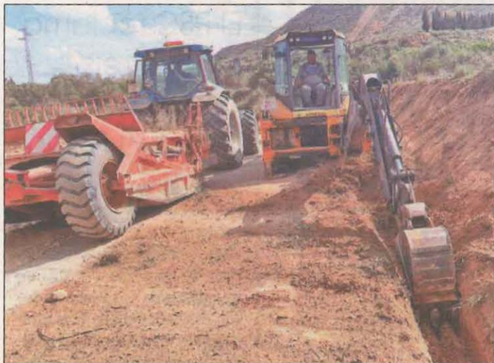
FOTO: Aj. Aitona/ Els treballs s'estan duent a terme al polígon 15
