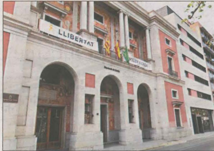
FOTO: LM / Imatge de la façana de la Diputació de Lleida
