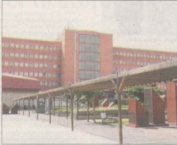
L'edifici prefabricat estarà ubicat en aquesta plaça.
